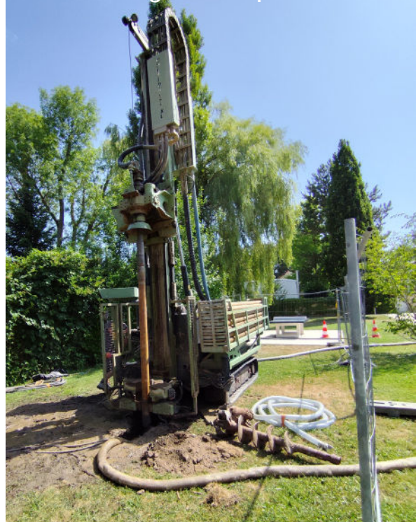
Début du forage sur l'Espace Doisneau
